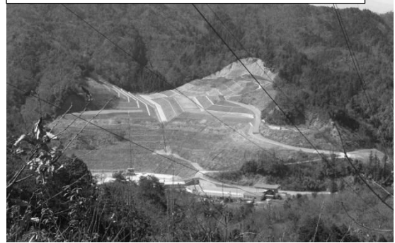
工事完了後の現地の様子(平成 25 年 3 月撮影)
