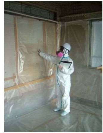
写真 2-1-2 アスベスト除去現場
