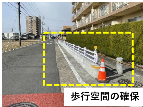
【（対策例）ガードパイプ設置】
