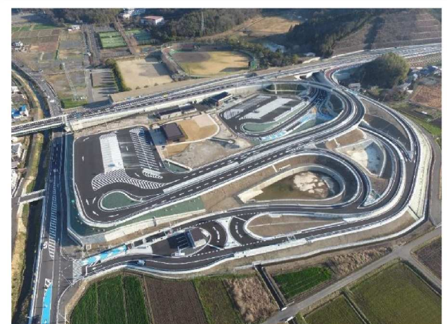
新しい玄関口 岐阜三輪スマートインターチェンジ
