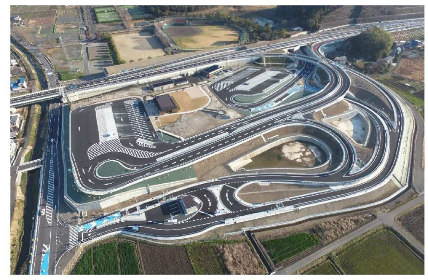
岐阜三輪スマートインターチェンジ開通 (道路整備の推進)
