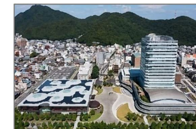
市庁舎/みんなの森 ぎふメディアコスモス
