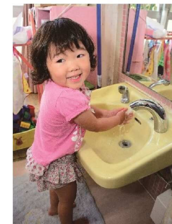
手洗い場蛇口の自動水栓化
