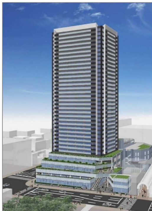
高島屋南地区第一種市街地再開発事業 「柳ヶ瀬グラスル 35」
