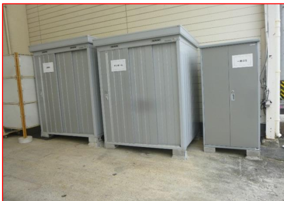
廃棄物保管庫の設置状況
