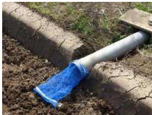
取水口への網の設置
