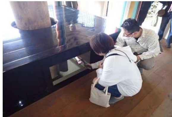
心柱が地面から浮いている様子を覗き込む参加者
