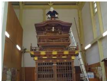
加納天満宮の山車の修理
