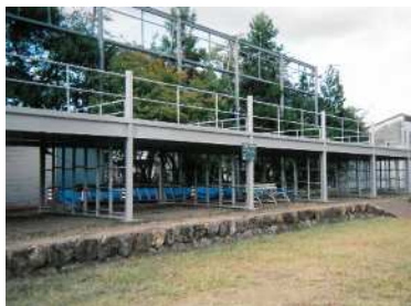
立火棚の修繕
