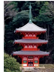
建築当初の姿に復原した三重塔
