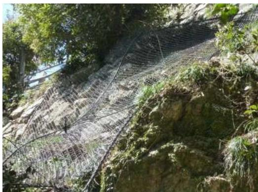
写真 3-27 天守南西部石垣落石防止網設置状況（部分）
