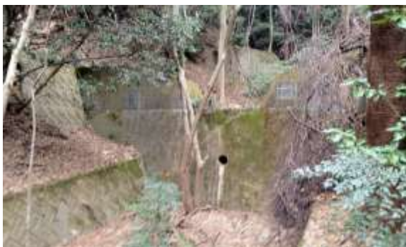
写真 2-33 治山施設(山麓部 堰堤)
