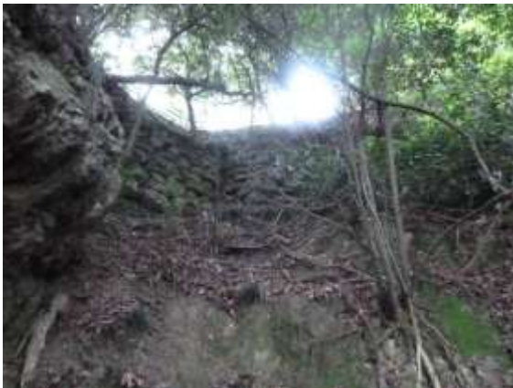
写真 2-9 天守台南西通路南側の石垣 樹木によって、孕み出しや崩落などの影響が認められる。見通しも悪い。
