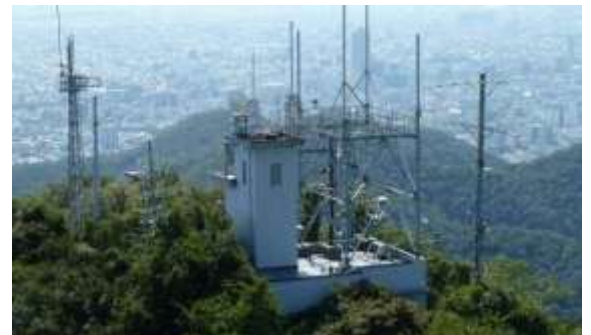
写真 2-44 無線中継所(山上部)
