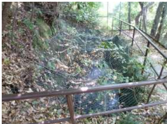
写真 2-11 上台所下場の井戸跡(北側) 手摺・ネット等による安全対策がされている。
