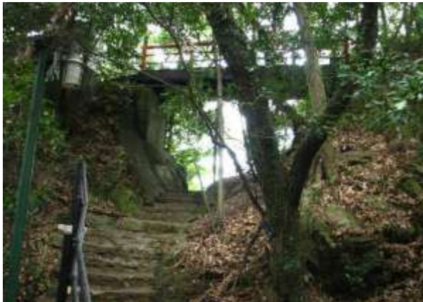
写真 2-12 堀切 近世絵図で「切通」となっている場所。鉄骨製の橋が架けられている。
