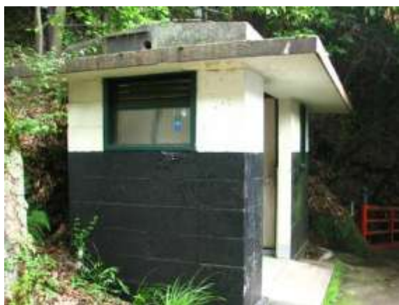
写真 2-28 老朽化した便所(山上部)
