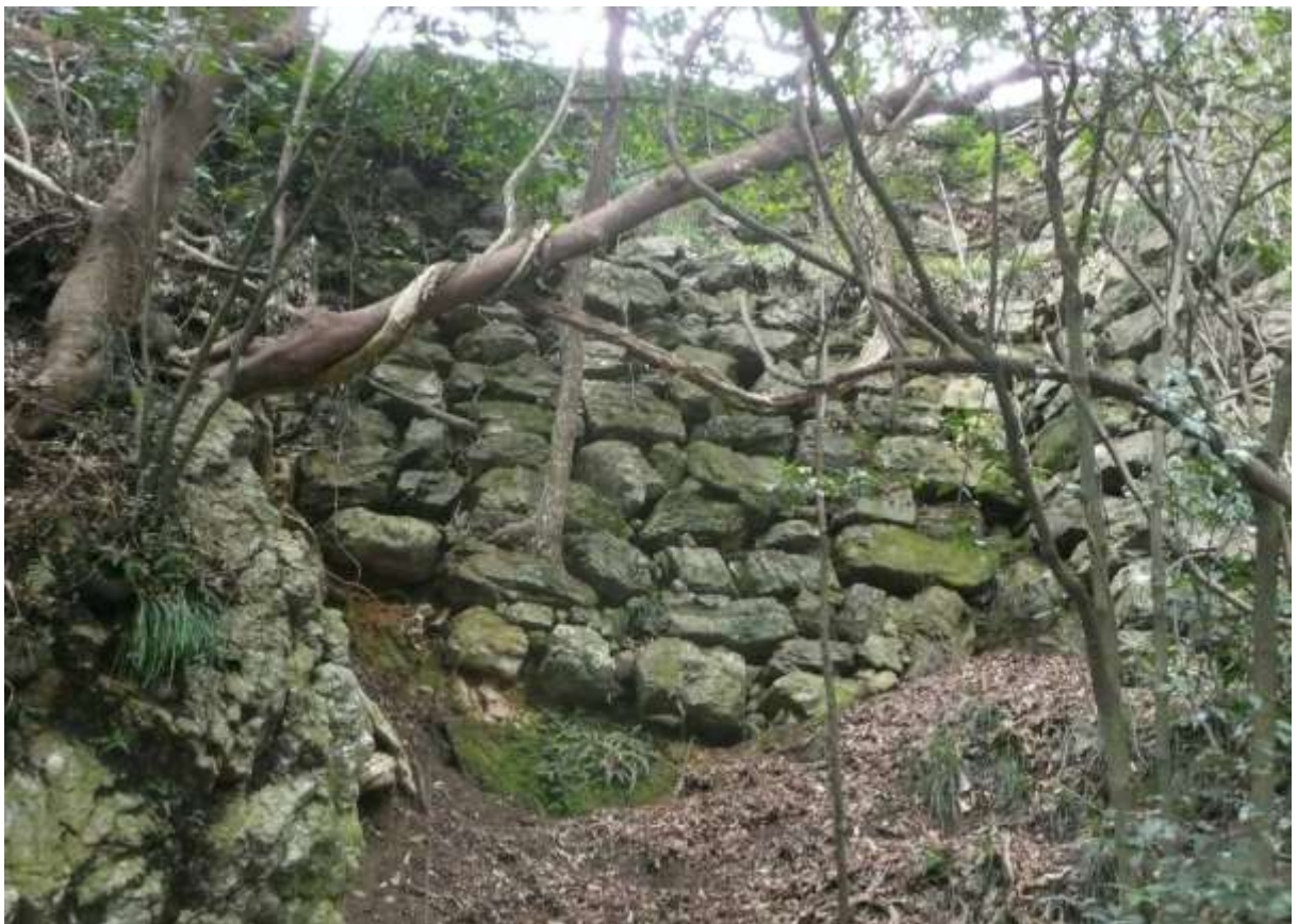
巻頭 6 〈現在の状況〉 山上部天守台西尾根南斜面石垣(南から)
