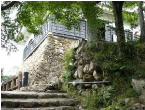
写真 2-7 岐阜城模擬天守脇の石垣 積み直された部分もあるが、戦国時代の石垣と推定できる。
