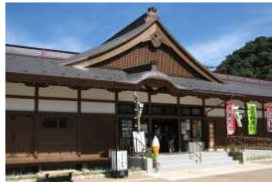
写真 2-51 岐阜公園総合案内所
