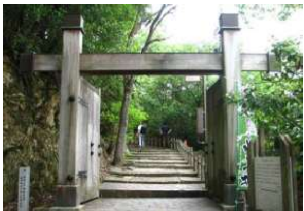
写真 2-37 冠木門(山上部・一ノ門西)
