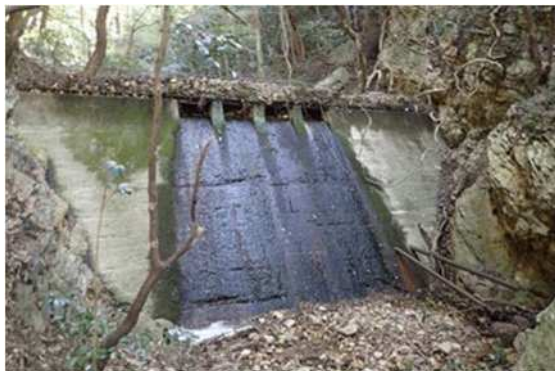
42. 山麓部 治山施設 (堰堤、西から)
