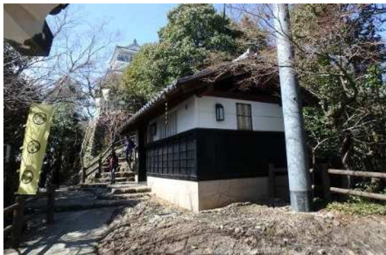
9. 山上部 便益施設 (資料館横トイレ、東から)
