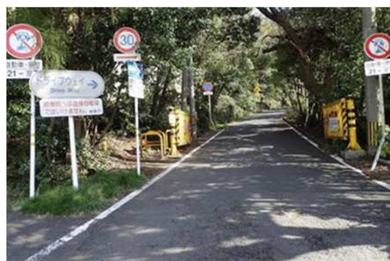
74. 山林部 公益施設 (金華山ドライブウエー、西から)
