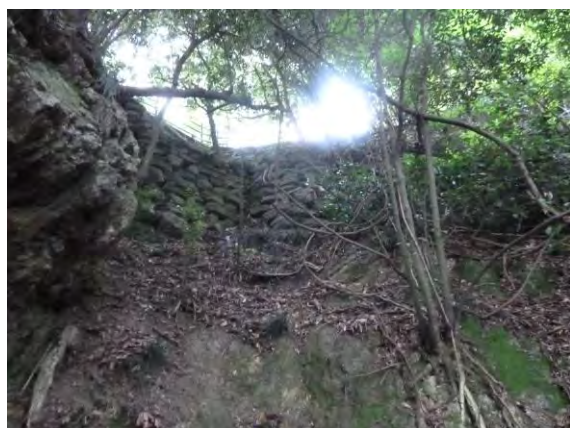
写真 2-3 天守台南西通路南側の石垣
