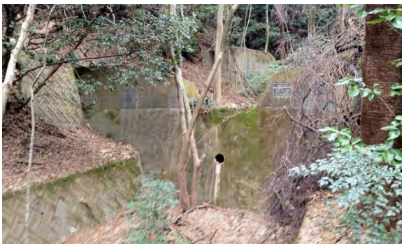
写真 2-25 治山施設(山麓部 堰堤)
