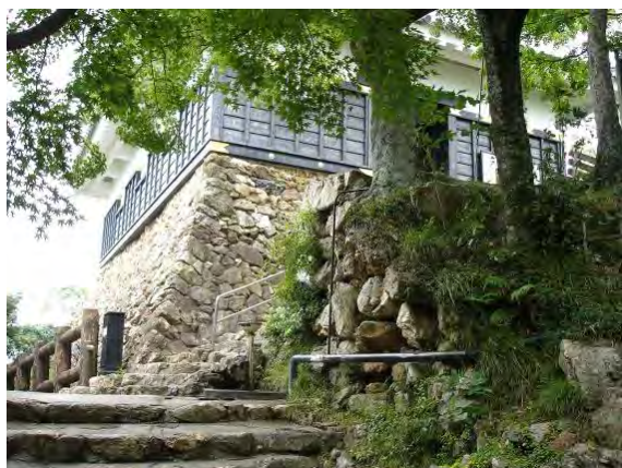
写真 2-1 岐阜城天守脇の石垣
