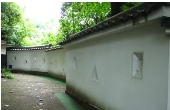
写真 2-31 コンクリート塀（山上部・下台所）
