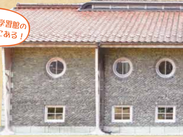
旧ポンプ室とはまた違った壁面。外側に鉄筋が出ているのが特徴。
