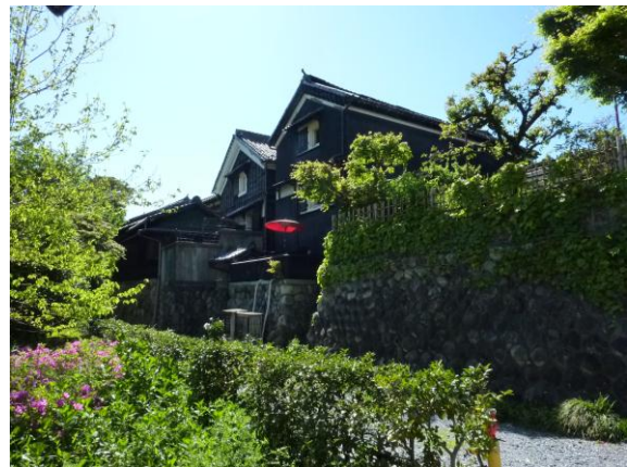
写真 2-12 土蔵の土台の石垣
