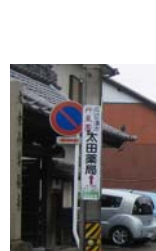
道路標識の電柱への添架イメージ
