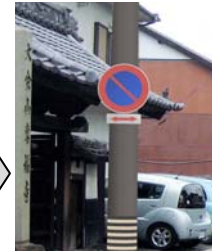
道路標識の電柱への添架イメージ
