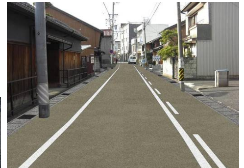
地道風舗装、洗い出し側溝の整備イメージ
