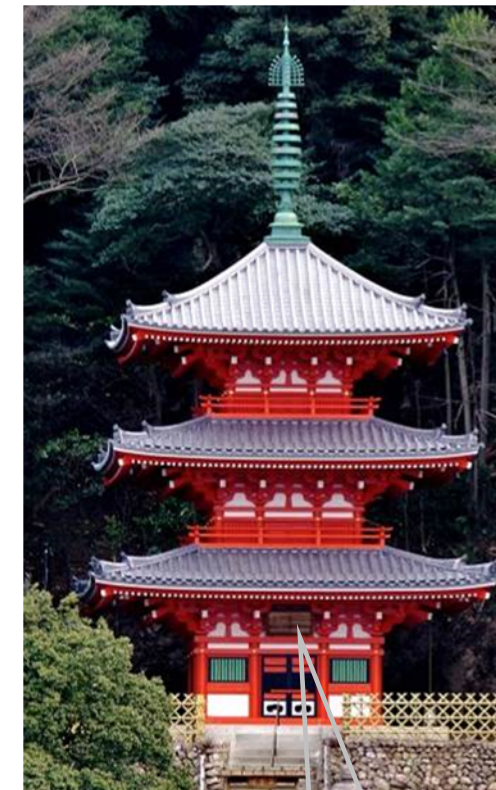
修復を終えた三重塔(平成29年)
