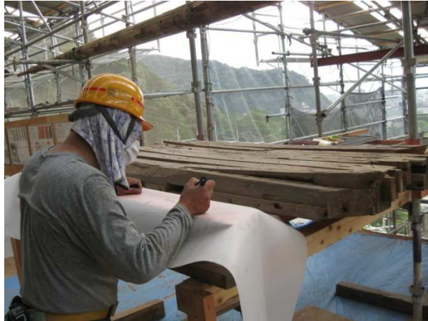
実測結果をトレッシングペーパーへ写す様子
