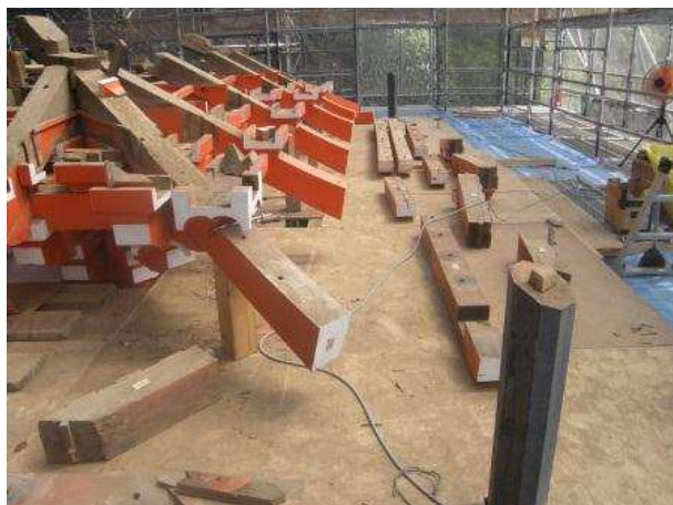
三重組物を解体する様子
