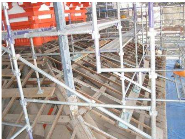
二重屋根の様子
