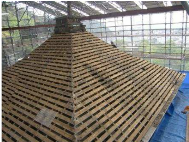
三重屋根のトントン葺き撤去完了
