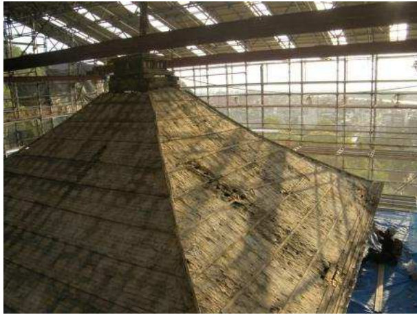
三重屋根の瓦撤去完了
