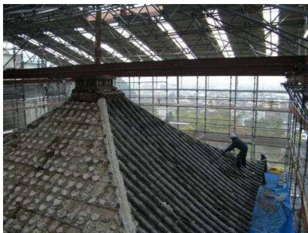
三重屋根瓦撤去の様子
