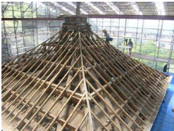
三重屋根の野地板撤去完了
