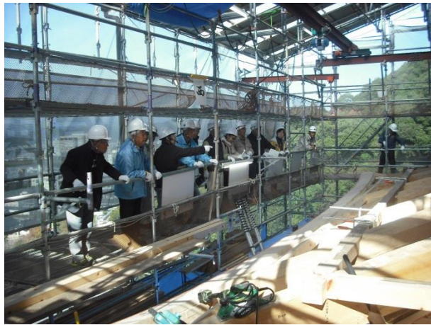
足場から三重の組立て状況の見学
