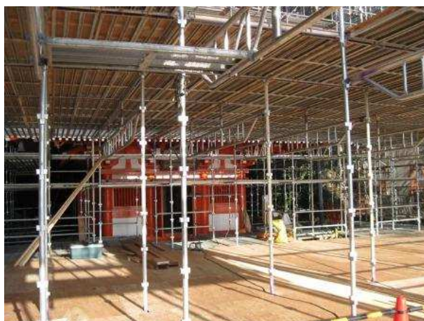
仮設足場内部
