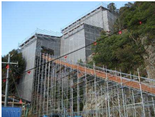
仮設足場外観
