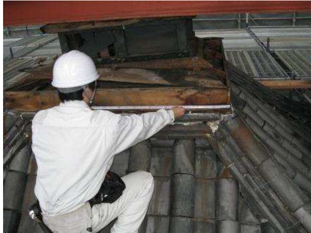
解体前の調査の様子
