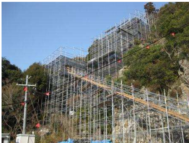
足場組立の様子
