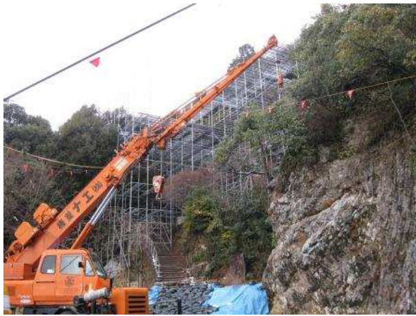
足場組立の様子
