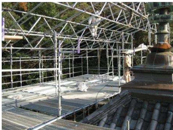
素屋根の骨組みを組立てている様子
