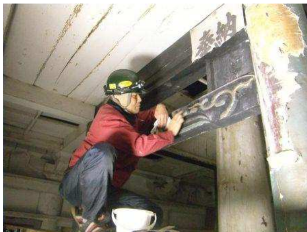
塗膜調査（研ぎ出し）
