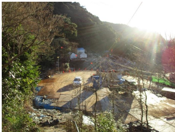
仮設事務所の撤去が完了しました。
