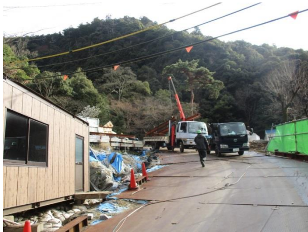
盛土の上に設置している仮設事務所等を撤去します。
