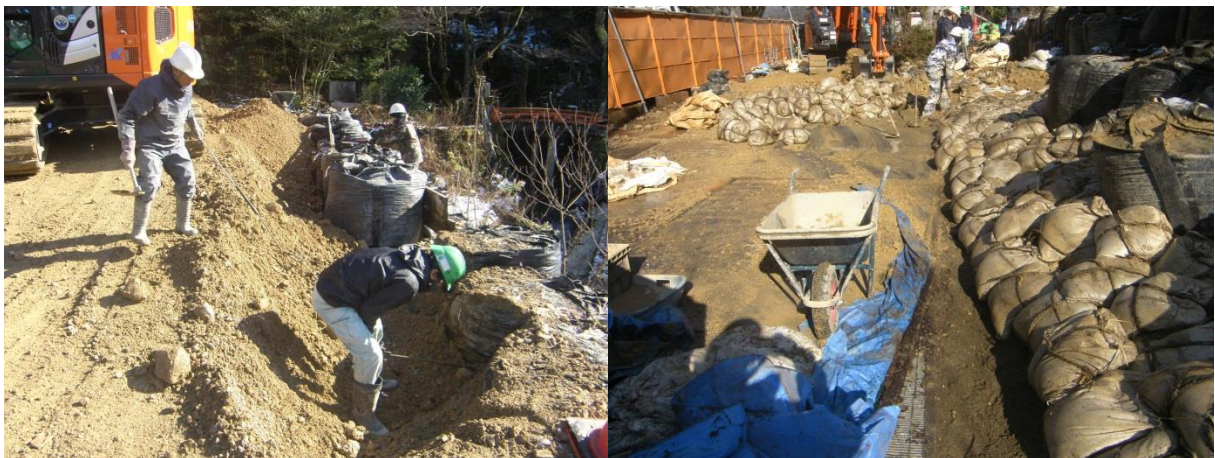
盛土を盛りかえて、人が通れるスロープを設置しています。
