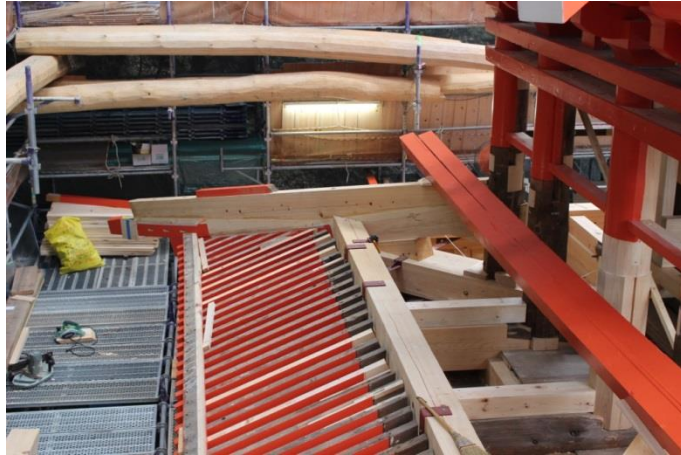
二重の屋根工事に着手しました。
