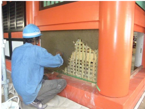
初重の土壁を施工しています。
