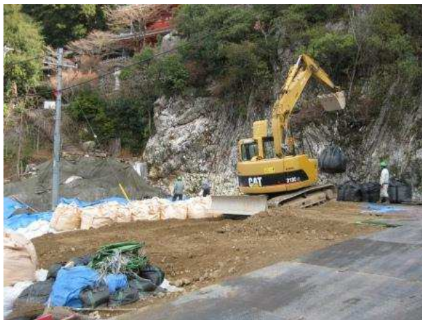
遺構を土嚢袋と盛土で保護する様子
