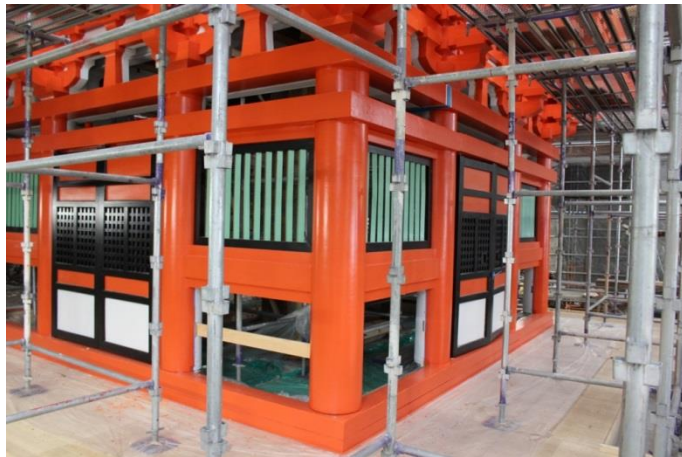
初重外部の塗装も完了してきました。
