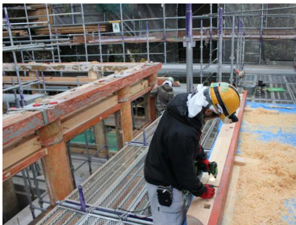
初重の組立てを行っています。
