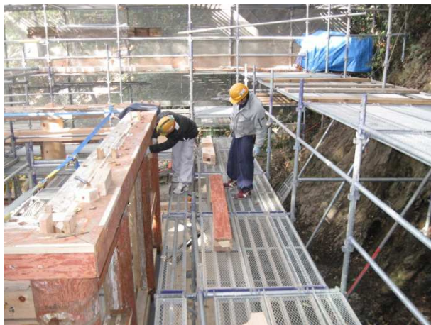
修復が完了した部材の組立てを開始しました。 (朱色がついている部材が修復した再利用部材です。)
