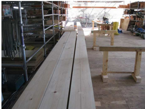
補強用の新しい部材も順次現場に搬入されてきます。
