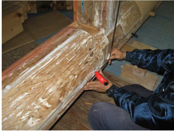
修復した柱と梁の接合部を確認しています。
