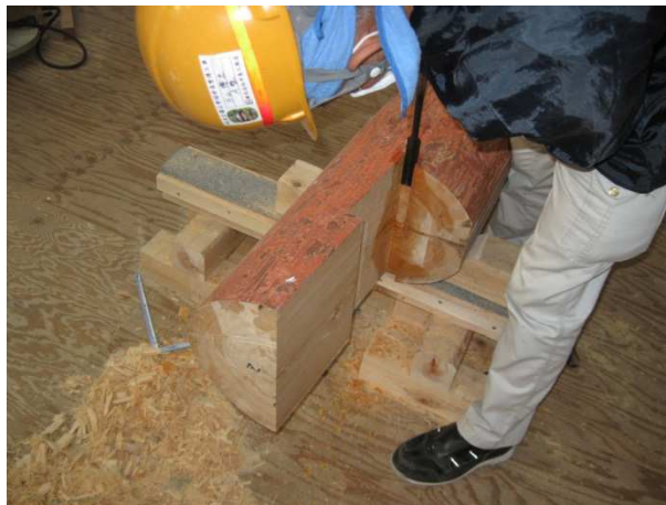
柱の腐朽部分を撤去して、継手を加工しています。
