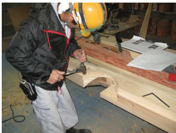
初層の内法長押を修復しています。
