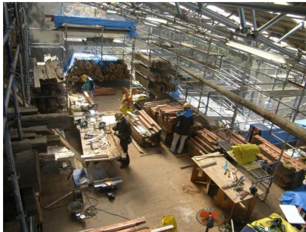
修復作業風景
