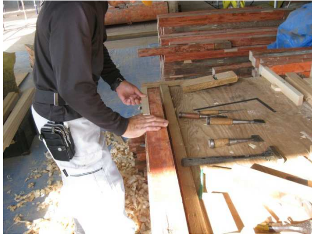
垂木を埋め木で修復している様子。 (埋め木とは、欠損部や腐朽部に木片を埋めて繕うことです。)
