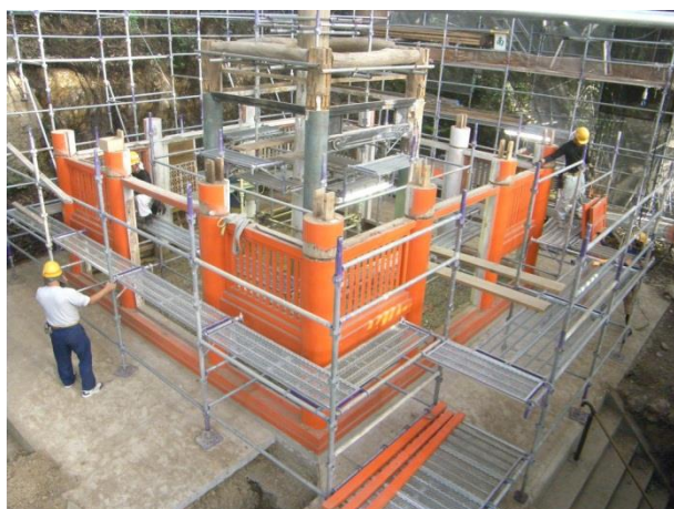
初重の壁を解体していきます。
