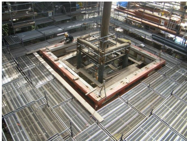
初重の屋根解体完了の様子。
