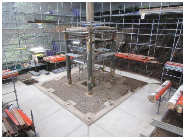
初重の四天柱と心柱だけの状況。
