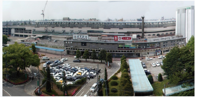
整備前の岐阜駅北口駅前広場（平成12年）
