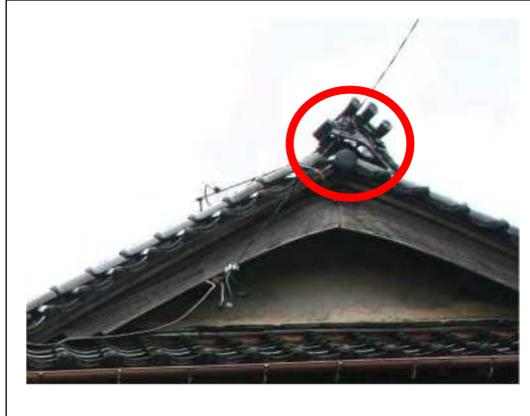
瓦の一部のずれ、破損
