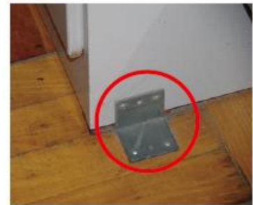
写真2. 棚の下部を床に固定した例
