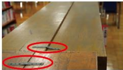
写真1. 棚同士の連結による固定の例
