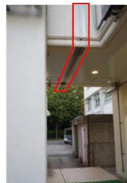
写真2. 通路の上部にあるエキスパンション・ジョイント
