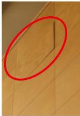
写真5. 内壁のずれ
