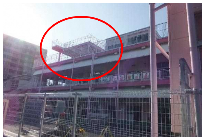
図 15 屋上への避難場所を増築した事例
