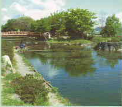
河渡橋の北1.5km
