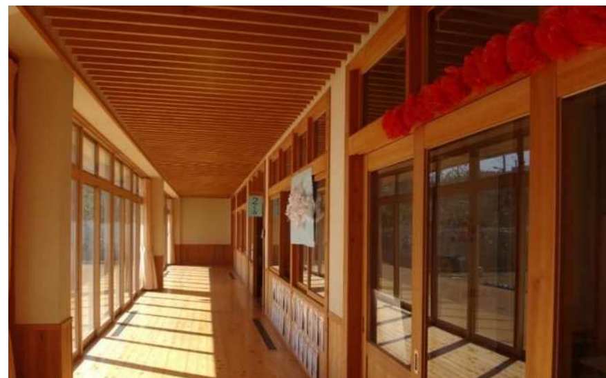
改修統合 王子が浜小学校
