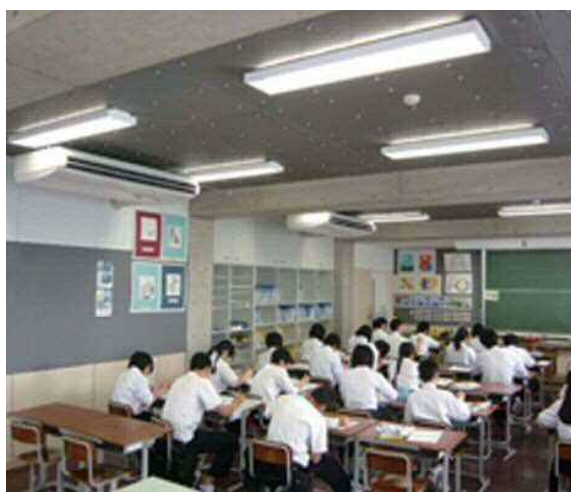
▽空調設備整備（エアコン設置）
