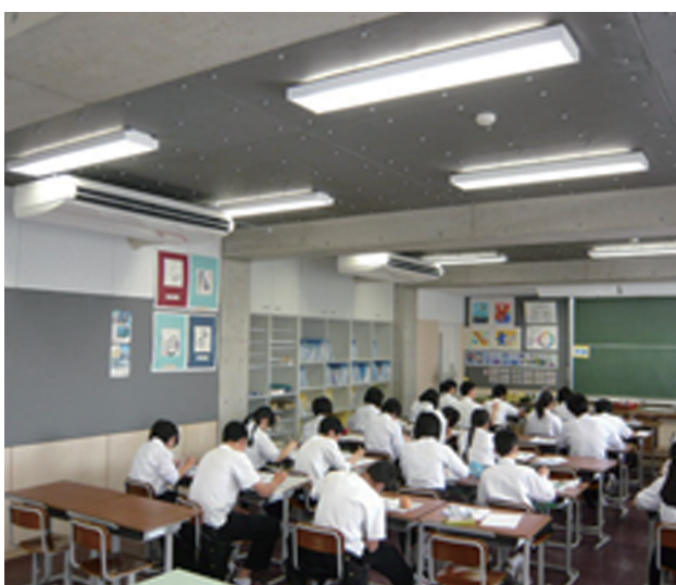
△空調設備整備（エアコン設置）
