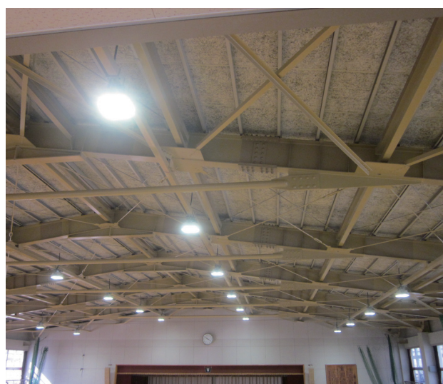
△非構造部材耐震補強工事（体育館天井）
