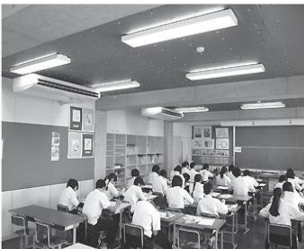
△空調設備整備（エアコン）
