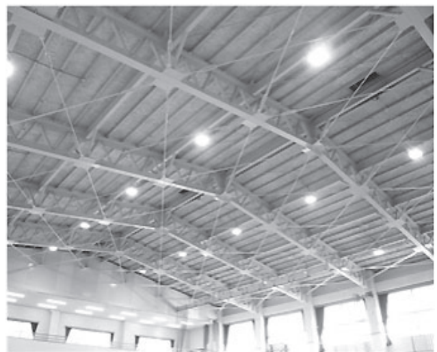
△非構造部材耐震補強工事（体育館天井）
