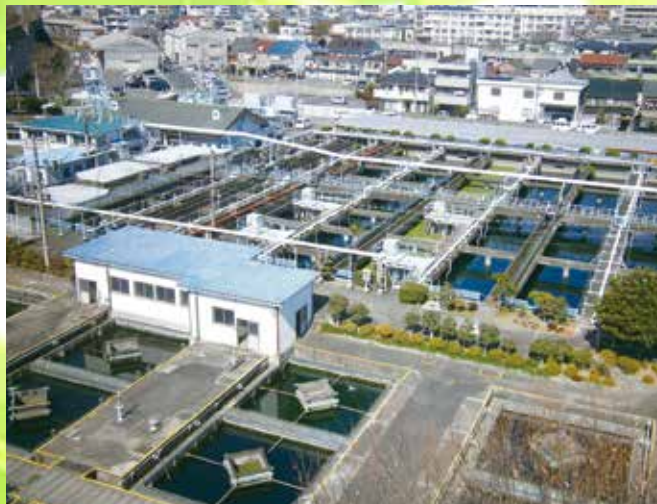
改築前の中部プラント
