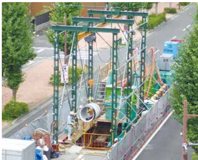
中部第1幹線管きよ布設工事（中部処理区）
