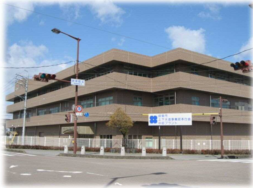
岐阜市上下水道事業部本庁舎
